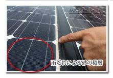
太陽光パネルはほとんどガラスで出来ています。ガラスという材質と、設置されている角度も味方し、ある程度の汚れは雨で洗い流すことは出来ます。しかし、雨の少ない季節は当然**砂**や埃による汚れ、**花粉・黄砂**と言った大気中に含まれる汚染物質による汚れは表面に残ってしまいます。また、雨が降っても**鳥の糞**や餌の飛沫による汚れはなかなか落ちませんし、砂や黄砂にいたっては雨だれによって引き起こされる砂の積層汚れになります。
